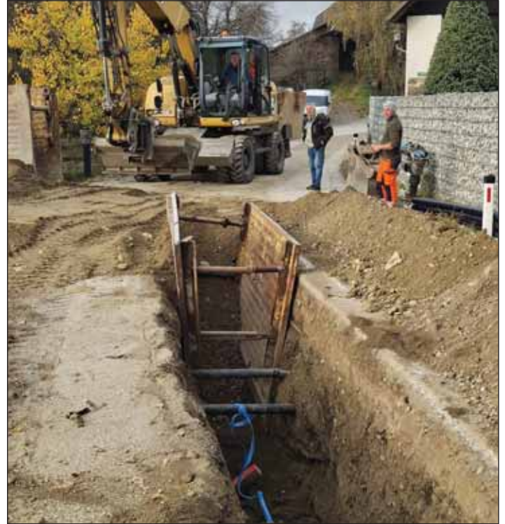
Die Sanierungsarbeiten an der mehr als 60 Jahre alten Wasserleitung in Überfeld konnten abgeschlossen werden.
