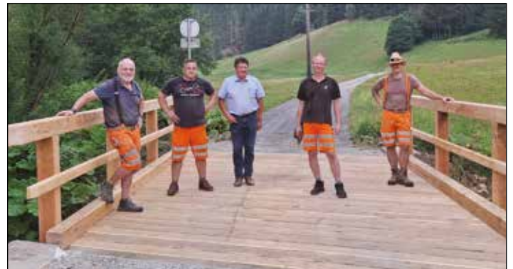
Die Hubenbauer-Brücke in der Wimitz wurde mit unseren Bauhofmitarbeitern komplett erneuert.
