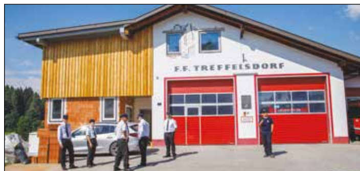
Der Rüsthausumbau schreitet zügig voran. Die FF Treffelsdorf freut sich, wenn auch Sie im Rahmen der Baustein-Aktion die Feuerwehr bei diesem Bauvorhaben unterstützen.
